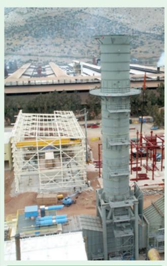
Gas-turbine exhaust waste heat discharge flue
